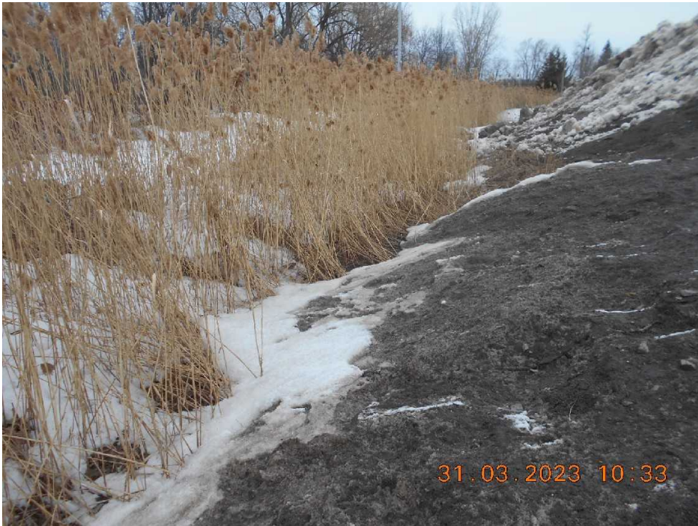
DSCN4149.JPG Image 5. Neige poussée dans fossé ouest, entre le point GPS 585 et la bassin de décantation. Le fossé est envahi par la végétation et non-profilé
