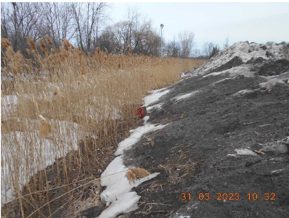
DSCN4147.JPG Image 3. Neige poussée dans fossé ouest, entre le point GPS 585 et la bassin de décantation. Le fossé est envahi par la végétation et non-profilé
