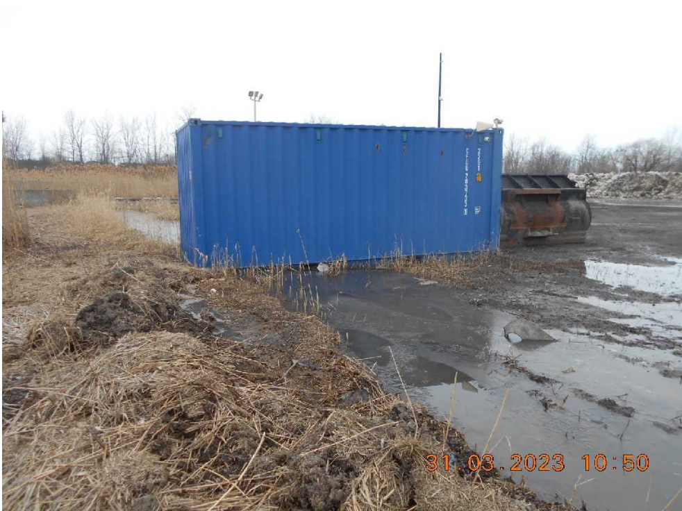
DSCN4162.JPG Image 11. Fossé sud non entretenu / non-profilé, bloc de béton et conteneur entreposés dans le fossé
