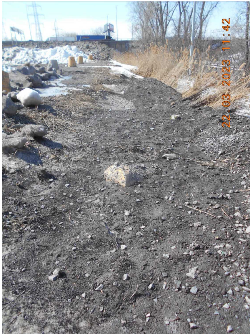
DSCN4122.JPG Image 3. Accumulation de neige dans le fossé
