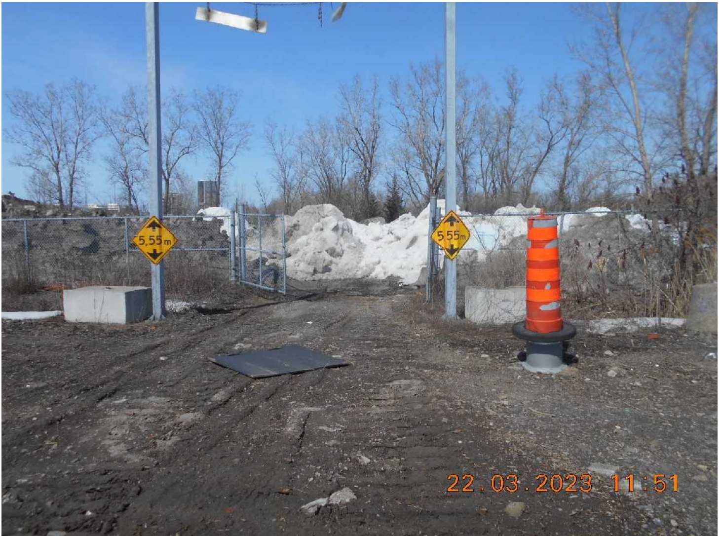
DSCN4132.JPG Image 8. 2e accès au site non sécurisé
