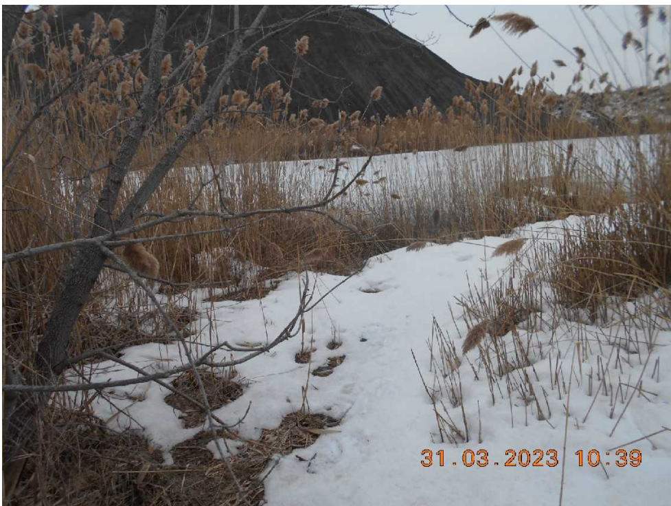
DSCN4153.JPG Image 6. Vue sur l'emplacement de la conduite souterraine de l'émissaire du bassin de décantation vers le cours d'eau 14
