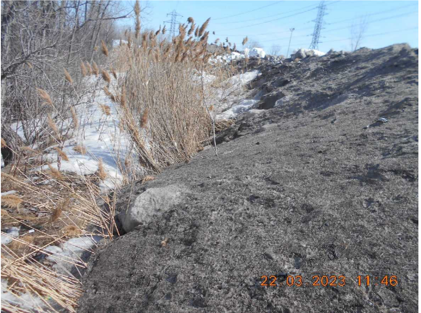
DSCN4126.JPG Image 7. Fossé non-entretenu (végétation) et accumulation de neige dans le fossé
