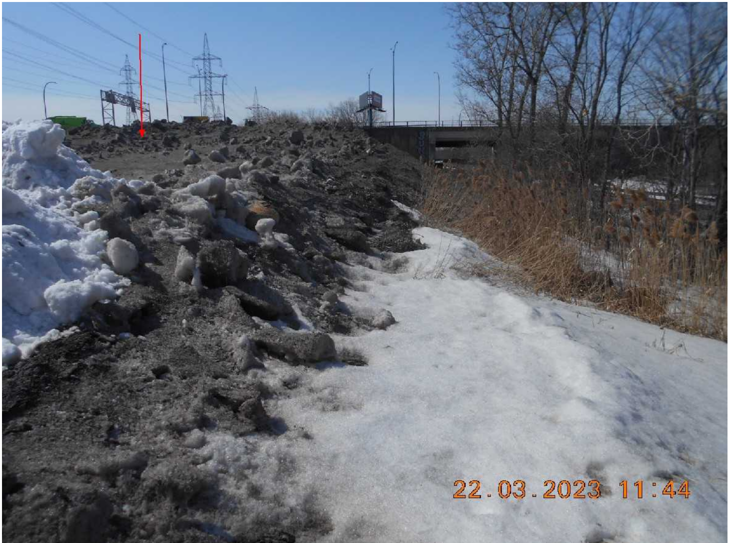
DSCN4123.JPG Image 4. Accumulation de neige à l'extérieur de l'aire autorisée, soit l'emplacement du bassin de décantation
